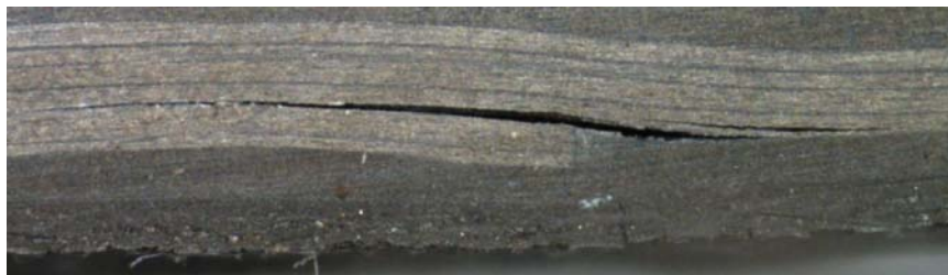
Figure 73 : Délaminage amorcé autour d'une reprise de plis
